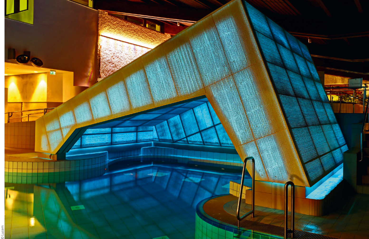
L'établissement thermal allemand de Bad Staffelstein concentre dans sa coque en béton translucide plus de 2 millions de fibres optiques.
